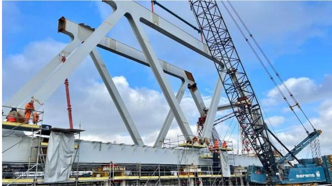
Le pont actuel sera remplacé par un pont métallique monumental de 1800 tonnes et 16,5 mètres de hauteur, en cours d'assemblage.
